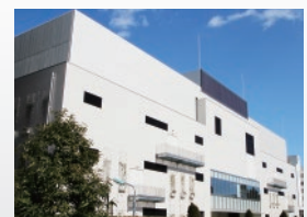
NSSOLデータセンター
